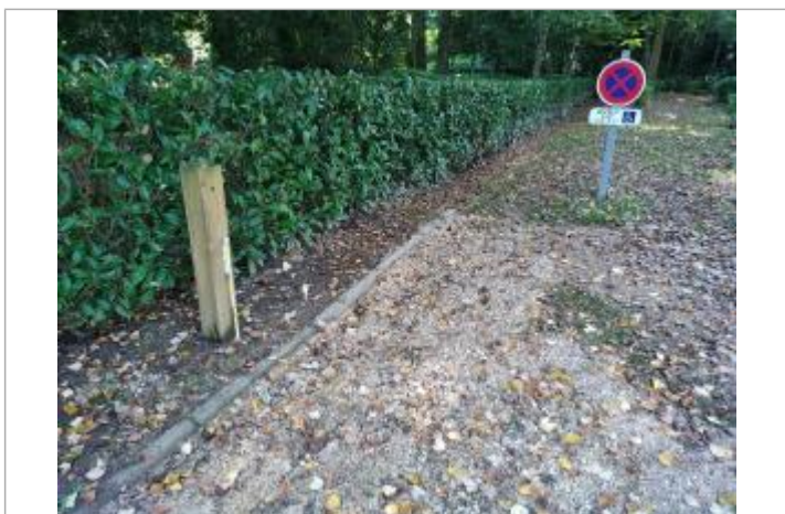
Vue sur la laisse d'inondation
