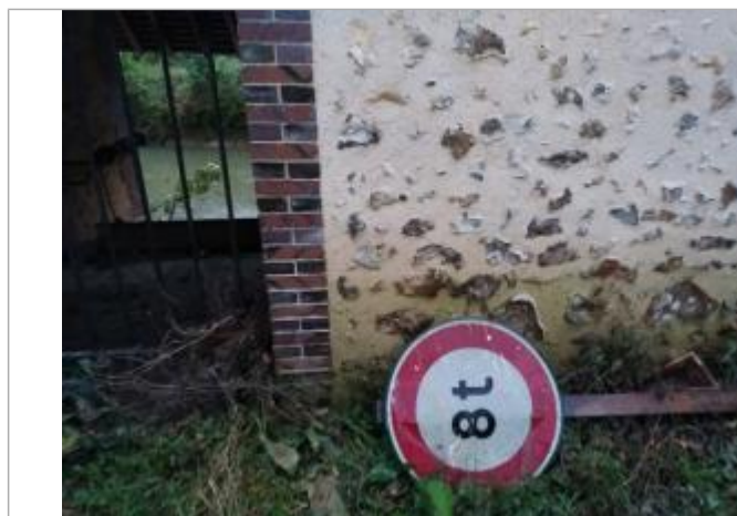
Vue sur la laisse d'inondation
