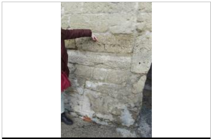
Marque d'inondation sur le mur à l'angle de la rue Mazelle et de la place Docteur Dax
