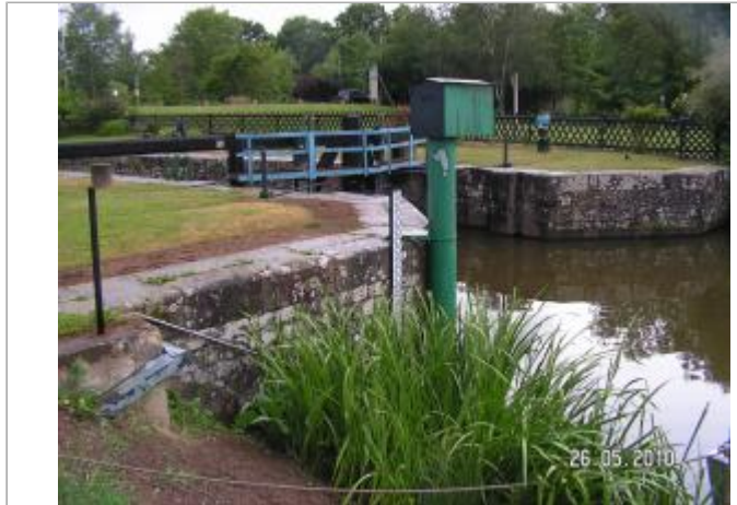
Echelle limnimétrique sur le bajoyer amont de l'écluse de Robinson à Saint-Grégoire
