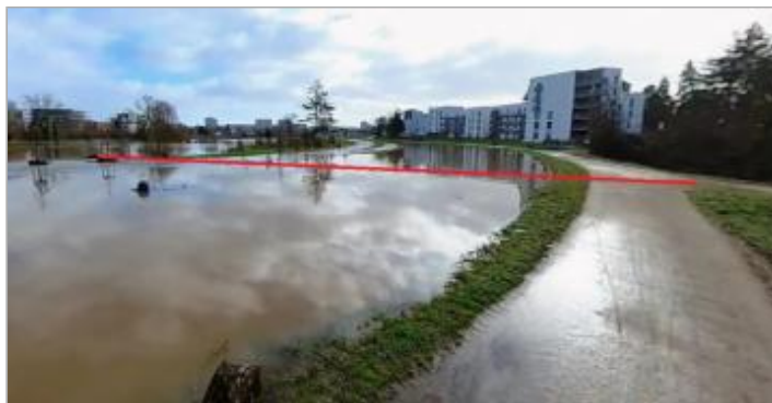
Berges de l'Ille canalisé au moment de l'inondation de janvier 2025
