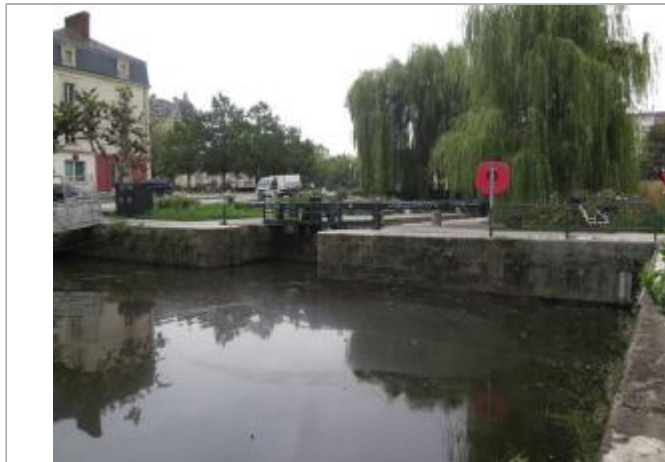
Ecluse du Mail à Rennes - échelle amont
