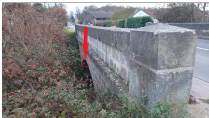
Laisse de crue à 243 cm/haut du muret du pont.
