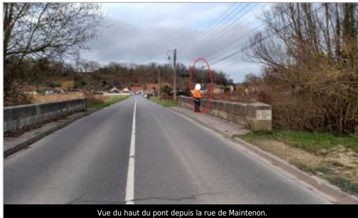
Vue du haut du pont depuis la rue de Maintenon.
