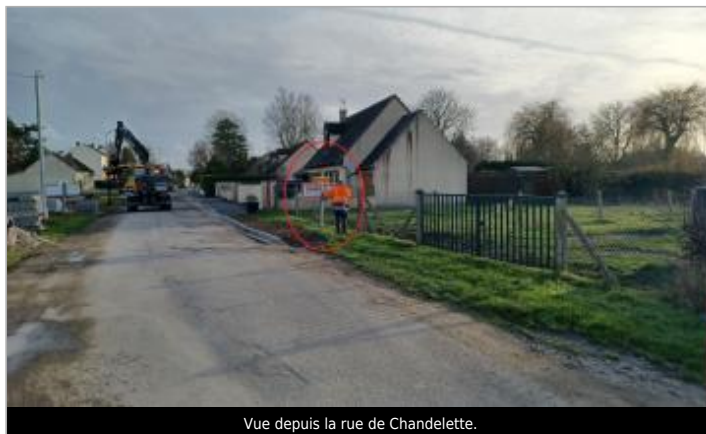
Vue depuis la rue de Chandelette.
