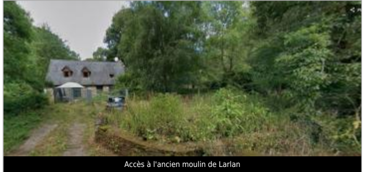
Accès à l'ancien moulin de Larlan
