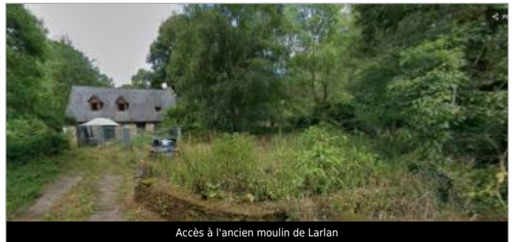
Accès à l'ancien moulin de Larlan
