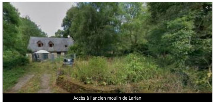
Accès à l'ancien moulin de Larlan
