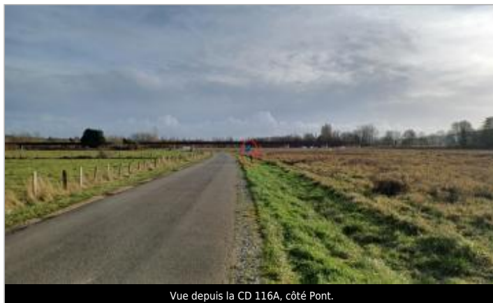
Vue depuis la CD 116A, côté Pont.
