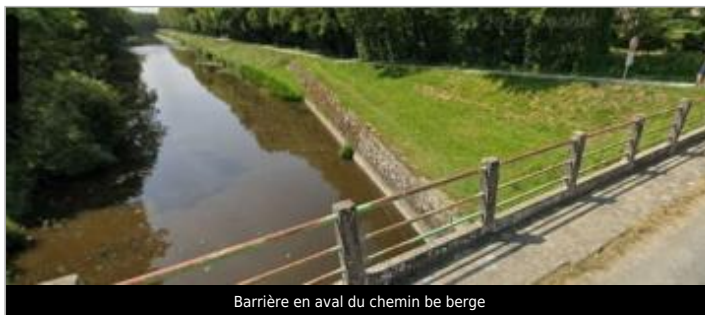
Barrière en aval du chemin be berge
