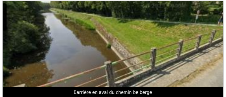
Barrière en aval du chemin be berge
