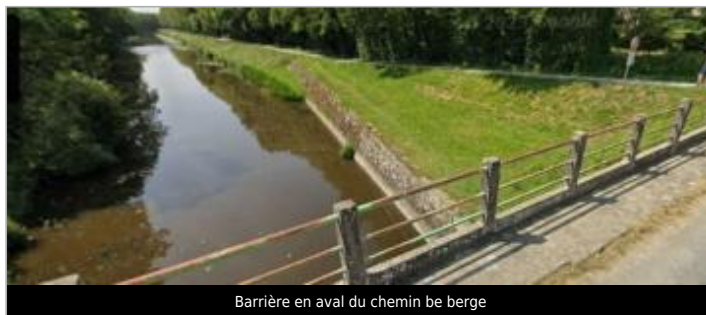
Barrière en aval du chemin be berge
