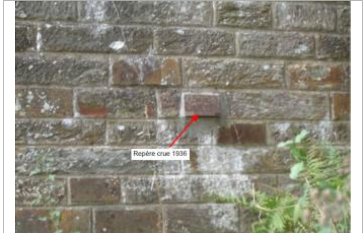
Repère de crue dans la structure du pont
