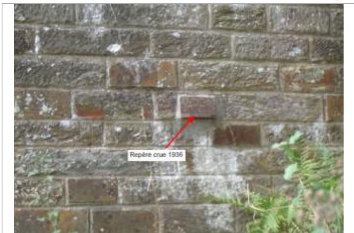
Repère de crue dans la structure du pont
