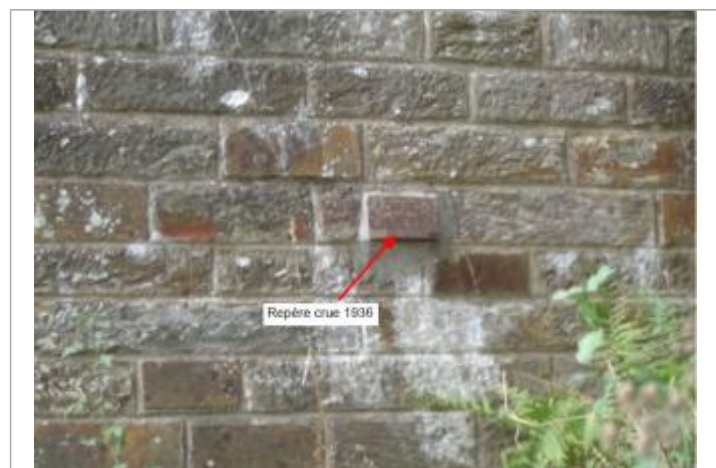
Marquage du niveau de hauteur de crue de 1936
