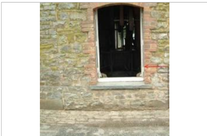
Fenêtre moulin de Roudun
