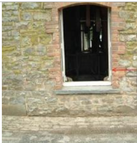
Fenêtre moulin de Roudun
