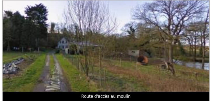
Route d'accès au moulin
