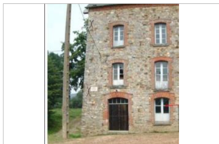
Fenêtre repère de crue du Moulin
