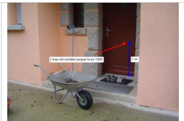
Vue de l'entrée de l'habitation
