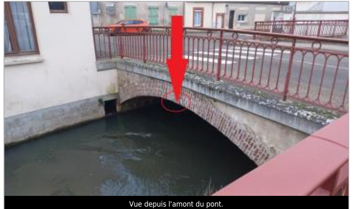
Vue depuis l'amont du pont.
