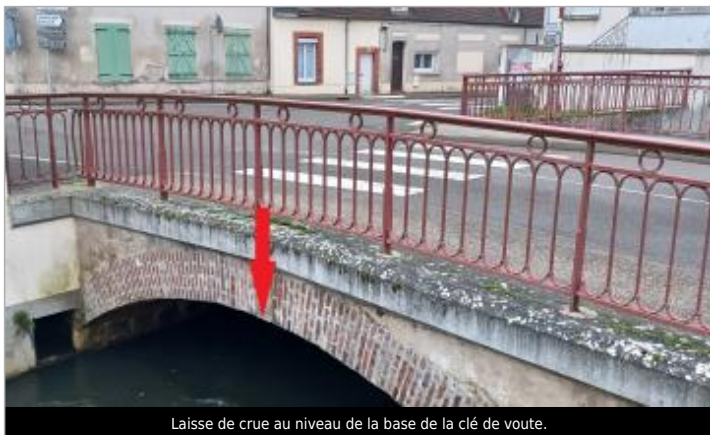
Laisse de crue au niveau de la base de la clé de voute.
