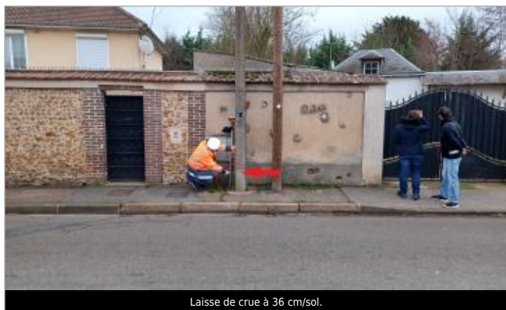
Laisse de crue à 36 cm/sol.
