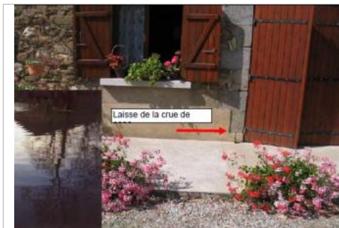
Dalle de la terrasse devant l'habitation
