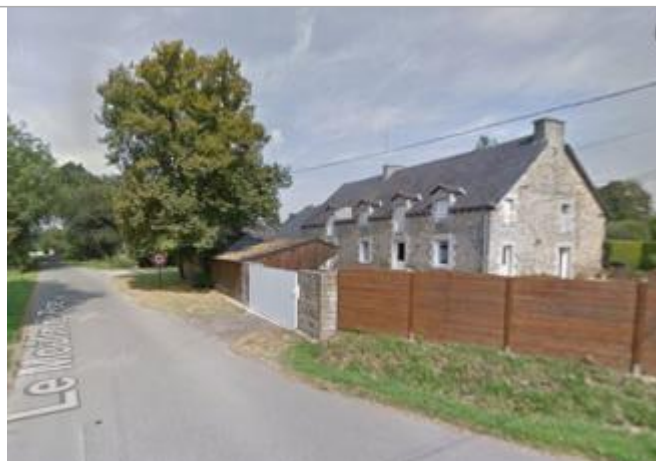
Accès à l'habitation du moulin du pont
