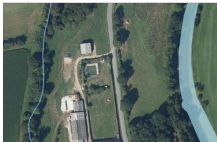
Vue aérienne de la ferme aux Forges
