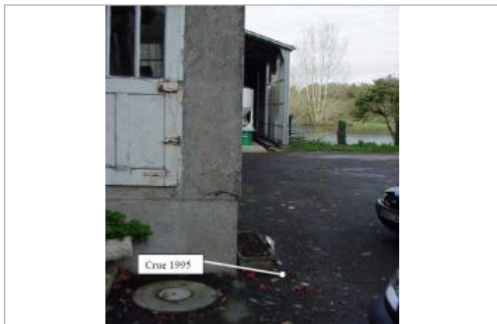
Limite de montée des eaux cours du moulin
