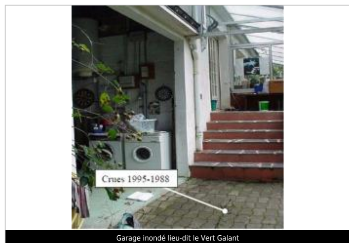
Garage inondé lieu-dit le Vert Galant
