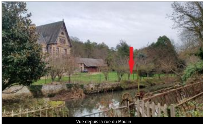
Vue depuis la rue du Moulin
