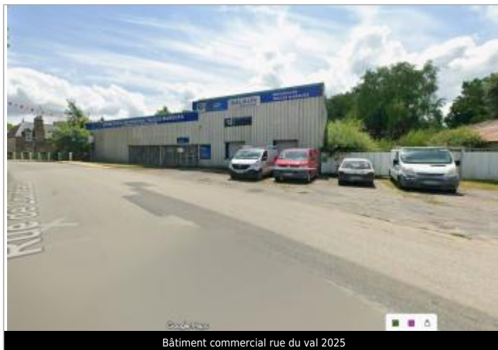
Bâtiment commercial rue du val 2025
