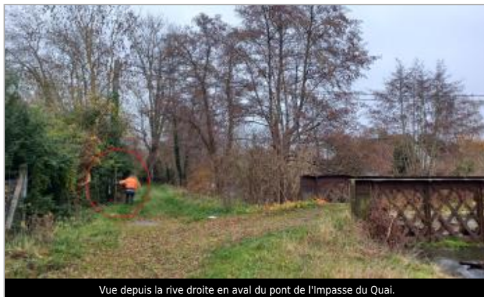
Vue depuis la rive droite en aval du pont de l'Impasse du Quai.
