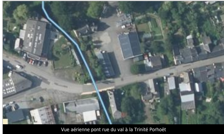
Vue aérienne pont rue du val à la Trinité Porhoët
