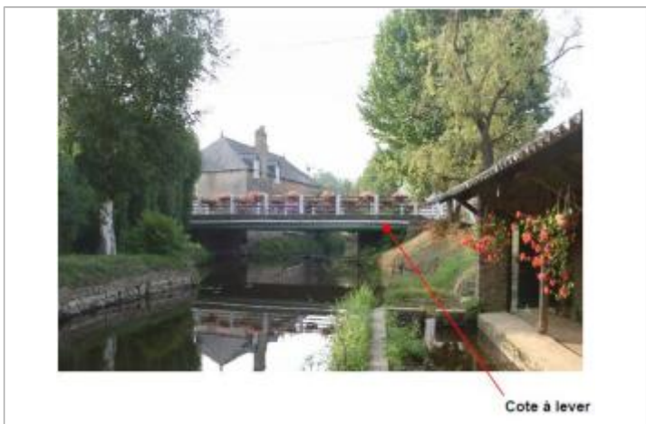
Repère au pont rue du val
