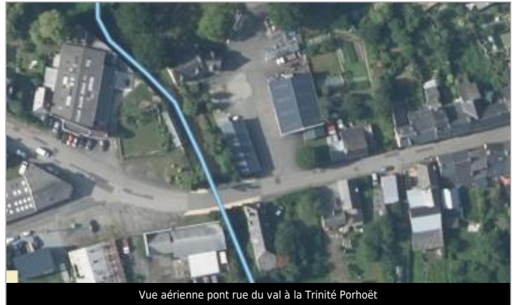
Vue aérienne pont rue du val à la Trinité Porhoët
