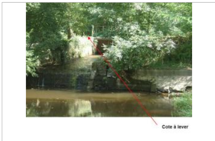
Repère TN vanne au moulin de Trégadoret
