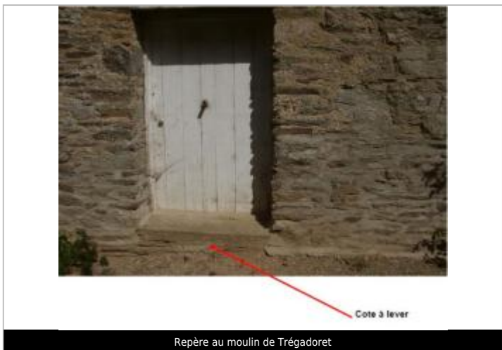
Repère au moulin de Trégadoret
