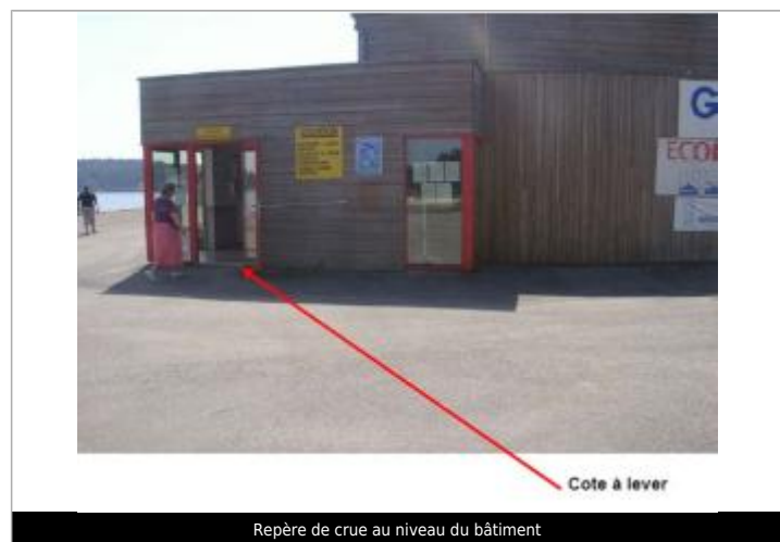
Repère de crue au niveau du bâtiment
