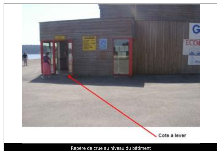
Repère de crue au niveau du bâtiment
