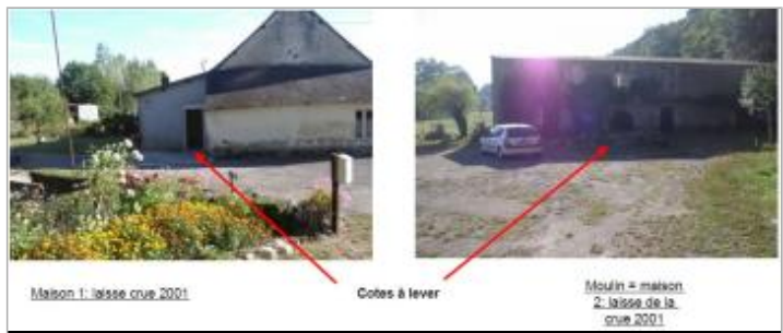
Repères de crue aux bâtiments
