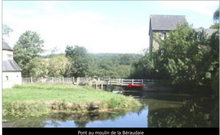
Pont au moulin de la Béroudaie
