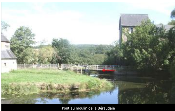
Pont au moulin de la Béraudaie
