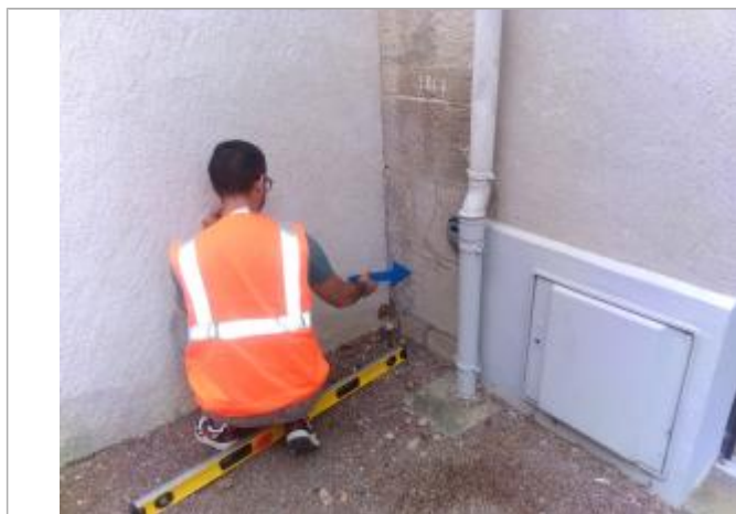
Vue du repère en 2025
