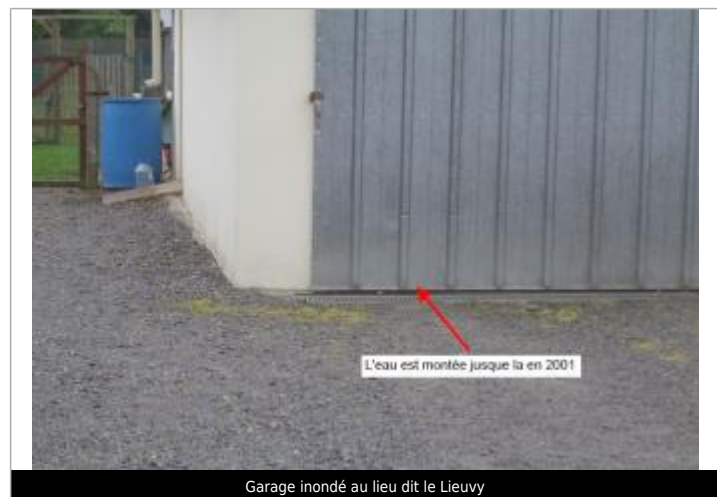
Garage inondé au lieu dit le Lieuvy
