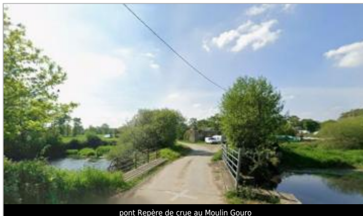
pont Repère de crue au Moulin Gouro
