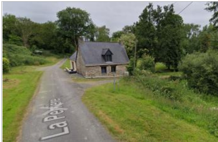
Route d'accès au Moulin de la Perrière
