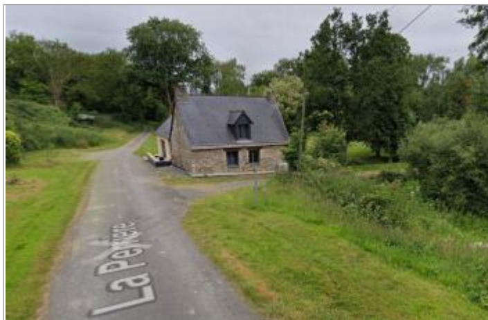
Route d'accès au Moulin de la Perrière
