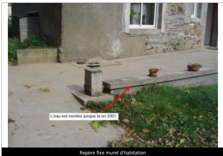
Repère fixe muret d'habitation
