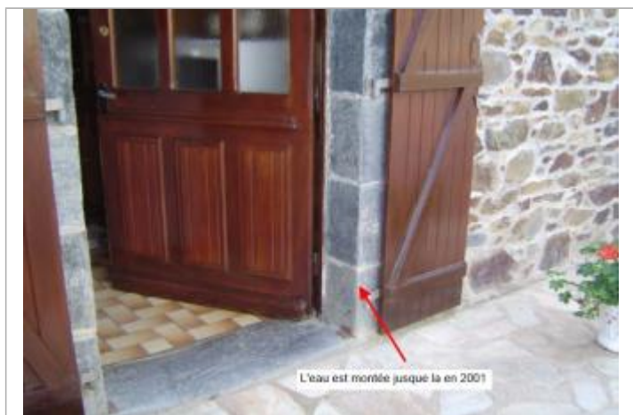
Seuil de la maison à la Chévelais
