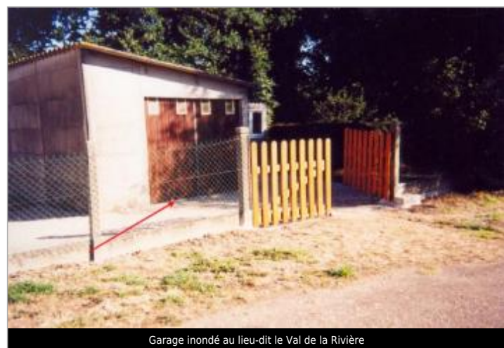
Garage inondé au lieu-dit le Val de la Rivière
