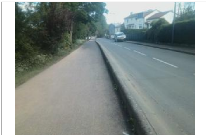
Vue du site - auteur : Artelia
