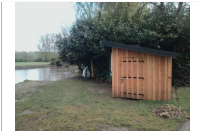
Vue du site - auteur : Artelia
