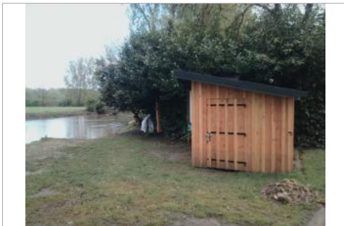
Vue du site - auteur : Artelia
