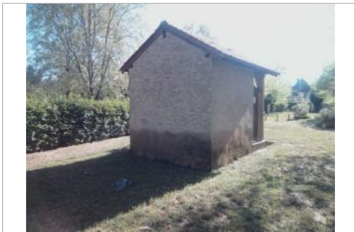
Vue du site - auteur : Artelia
