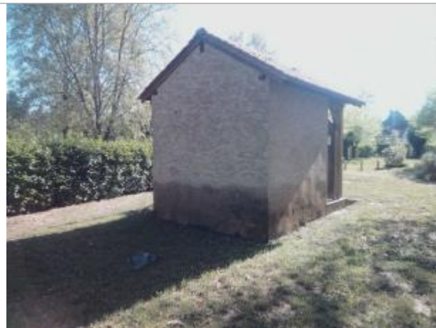
Vue du site - auteur : Artelia
