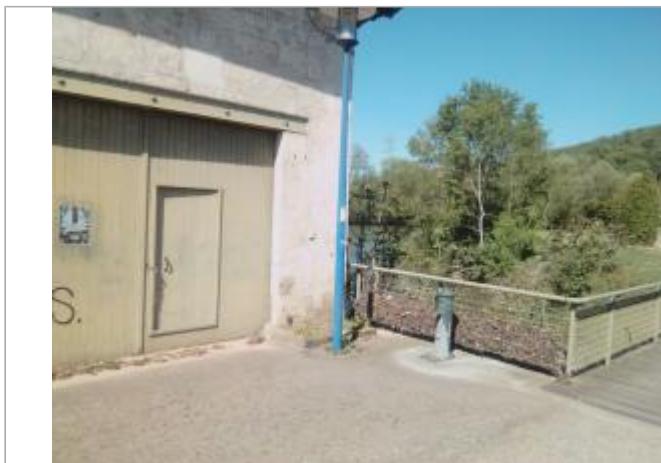
Vue du site - auteur : Artelia
