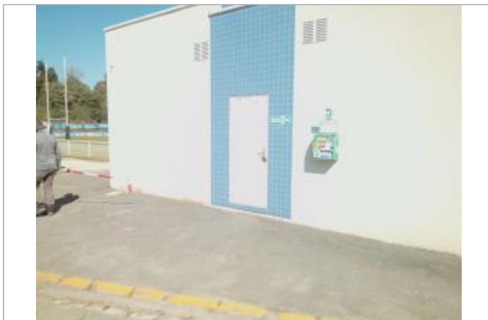
Vue du site - auteur : Artelia
